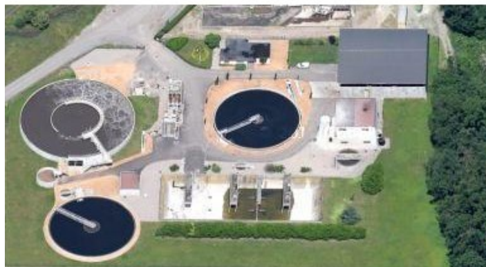
Station d'épuration de Pont du Château.
