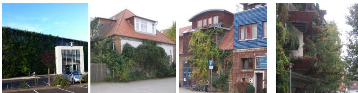
*Exemples : mur végétalisé à partir du sol, mur végétalisé à partir de dispositif implanté sur le mur vertical, mur de soutènement permettant le développement des végétaux.*
